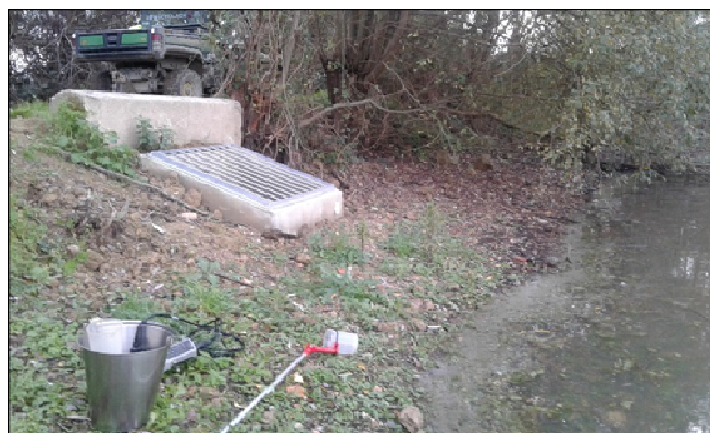
Exutoire Bassin n°3
